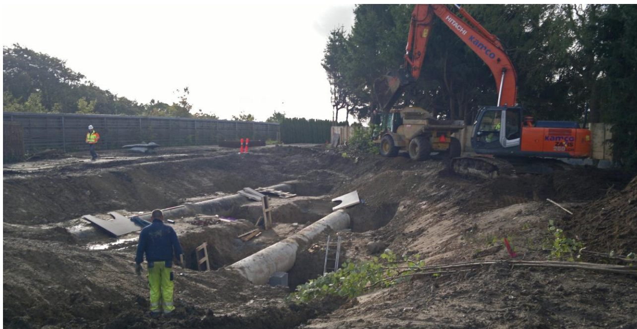
Her kan man se, hvordan vi arbejder på at gøre klar til at flytte den store vandledning fra Nordvand, der ligger mellem Pilekæret og motorvejen.
