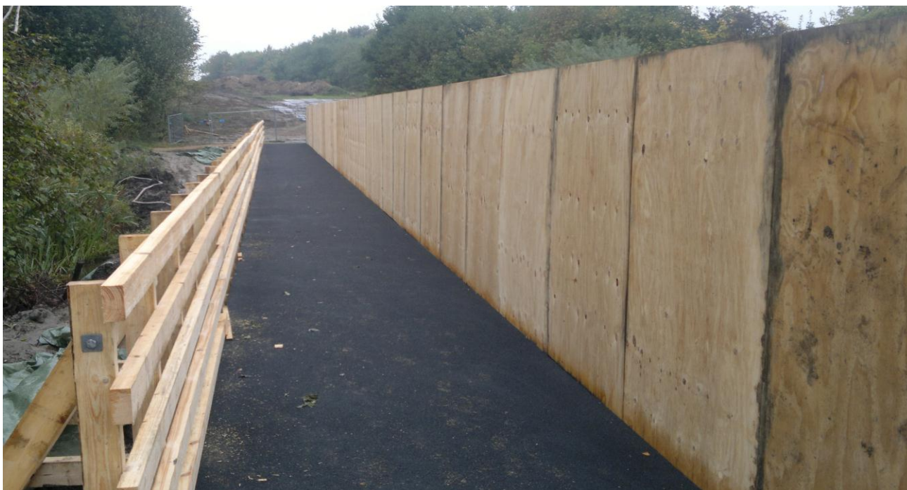
Vi har anlagt en midlertidig stibro for de daglige brugere af Tusindbenruten, mens vi omlægger ledninger og bygger mellem Pilekæret og motorvejen.
